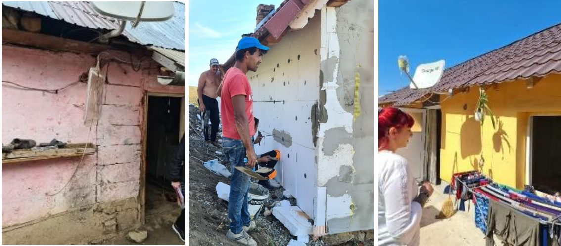
Renovierung eines Hauses in Artenie
